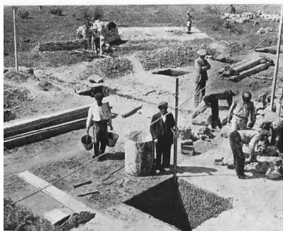
Un altre aspecte de les obres el dia 16 de juny.
